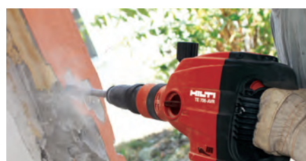
TE 700-AVR เหมาะกับงานสกัดเพื่อลอกผิวปูนฉาบ
