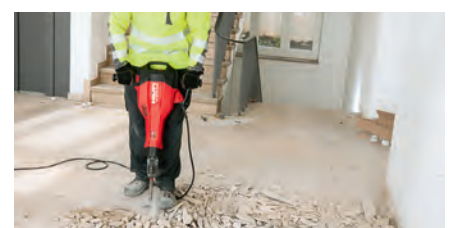
TE 2000-AVR เหมาะสำหรับงานสกัดพื้น หรือผนังทำมุม 45 องศา
