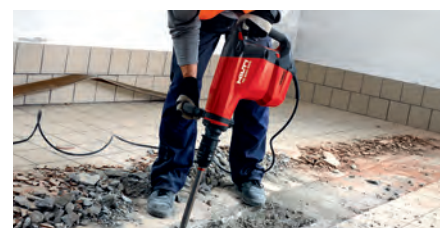
TE 800-AVR เหมาะสำหรับงานสกัดพื้นซึ่งให้กำลังการสกัดสูงมากถึง 21 J ทำงานได้อย่างต่อเนื่อง
