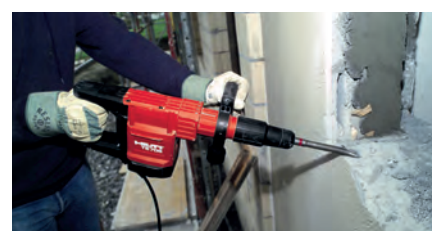
TE 700-AVR สะดวกต่อการใช้งาน โดยเฉพาะเมื่อใช้งานสกัดผนังก่ออิฐฉาบปูน
