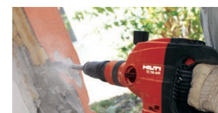
TE 700-AVR เหมาะกับงานสกัดเพื่อลอกฉาบปูนฉาบ
