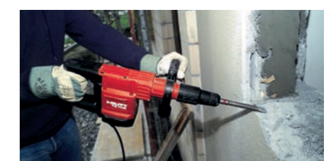
TE 700-AVR สะดวกต่อการใช้งาน โดยเฉพาะเมื่อใช้งานสกัดผนังก่ออิฐฉาบปูน
