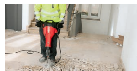
TE 2000-AVR เหมาะสำหรับงานสกัดพื้น หรือผนังทึบ 45 องศา
