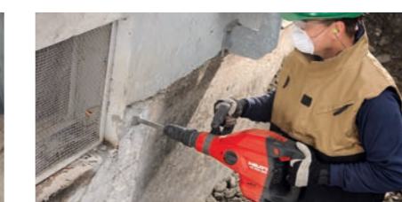
TE 700-AVR สามารถทำงานได้อย่างต่อเนื่อง เหมาะสำหรับงานสกัดเพื่อเก็บงาน
